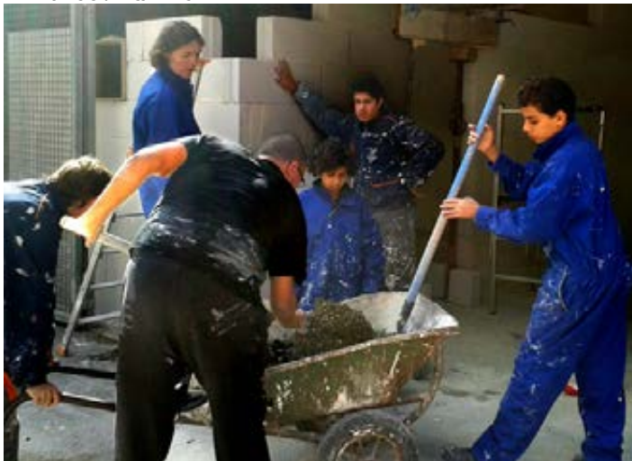
Chantier pédagogique Segpa Collège Barnier
