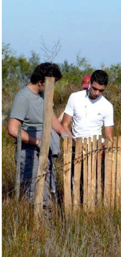
Chantier éducatif espaces naturels - Port Saint Louis
