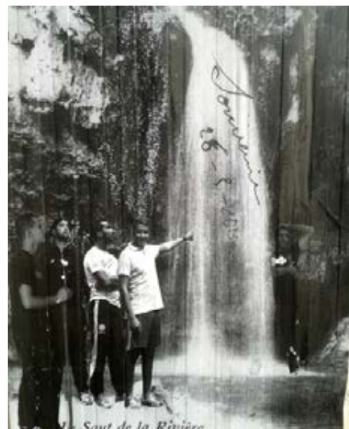
Montage photo chantier patrimoine - Cascade des Aygalades
