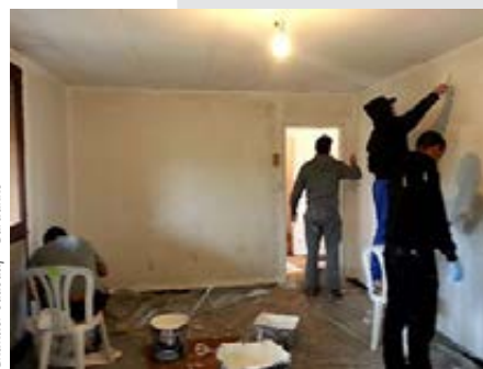
Chantier éducatif - Gardanne
